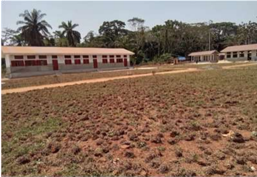
Photo 1: BCoCO/Ituri/Mambasa/PDL : Travaux de réhabilitation de l'EP SAYUNI
